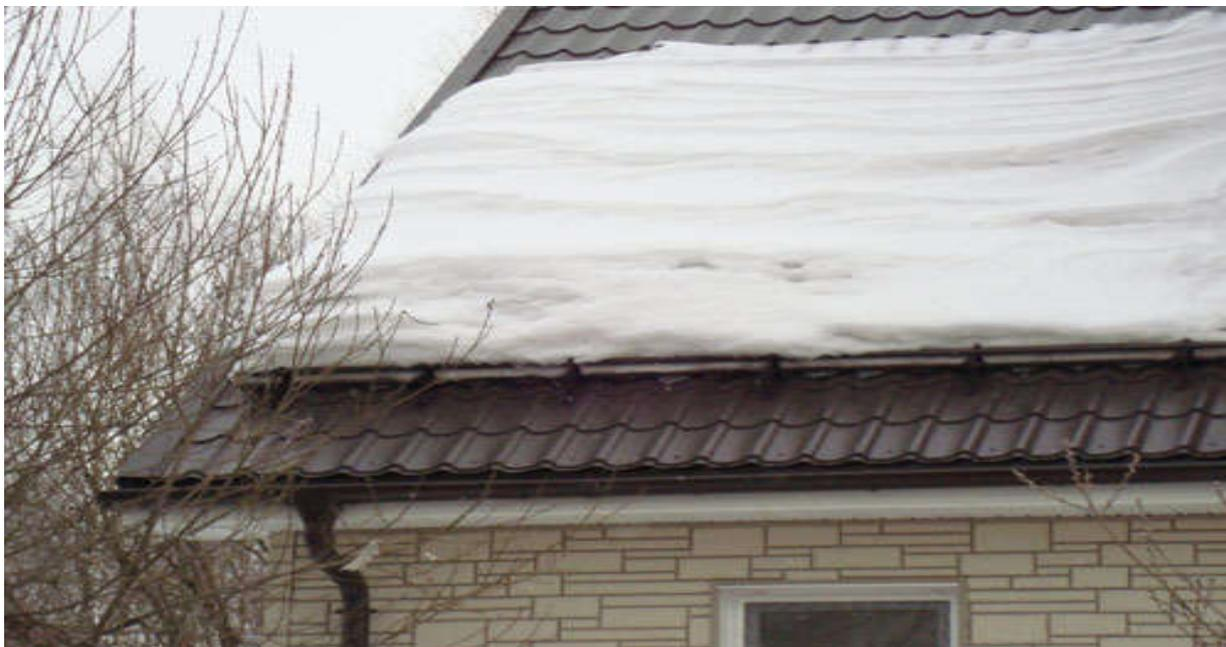
**Снегозадержатели** – оптимальное *решение проблемы внезапного обвала снега* с кровли в весенний период. Благодаря снегозадержателям тяжелые снежные массы *падают с крыши не лавиной, а постепенно и равномерно*, не повреждая при этом кровельное покрытие, и не угрожают безопасности окружающих.
